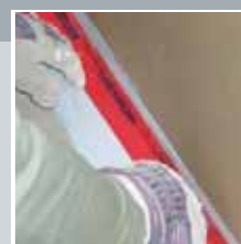
Τοποθέτηση μονωτικών ταινιών
