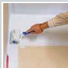
Επάλειψη της υπόλοιπης επιφάνειας
